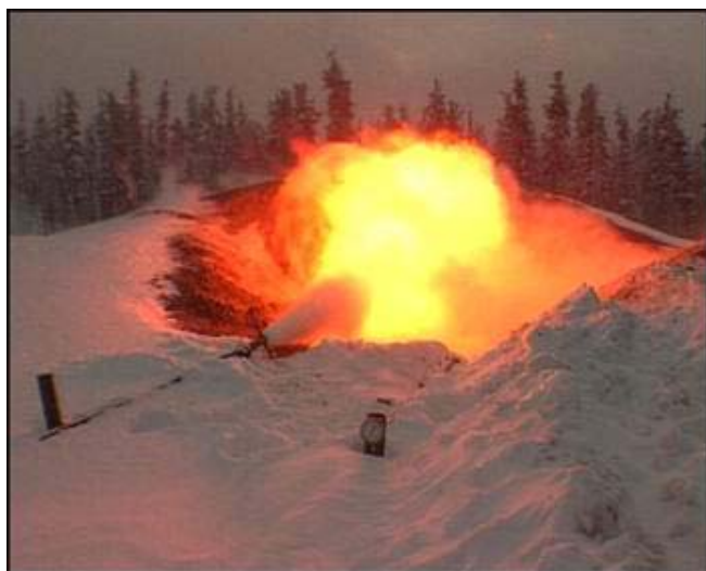
Рис.6. Сжигание газа при продувке трубопровода
